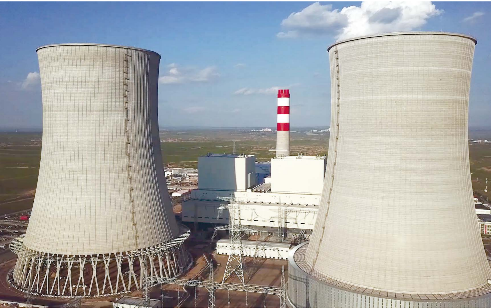
国电宁夏方家庄2x1000MW超超临界燃煤间接空冷机组
