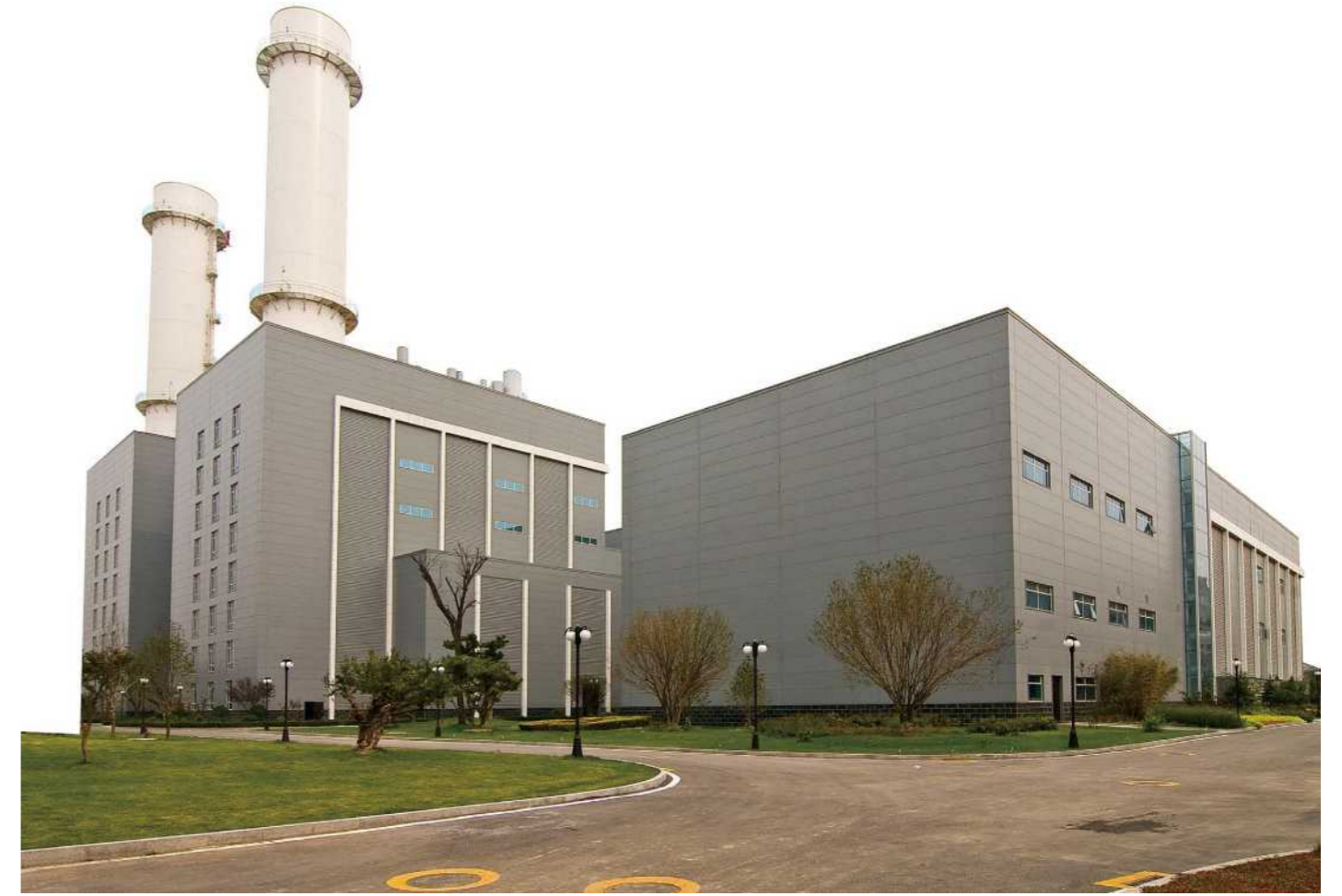
北京太阳宫2×350MW级燃气热电冷联供工程（2008年奥运会配套项目）
