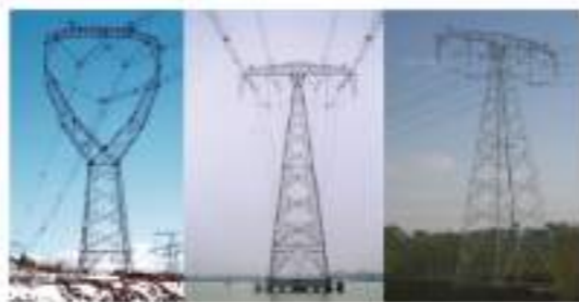
500kV紧凑型输电线路
