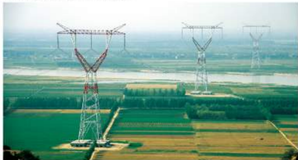
晋东南-南阳1000kV特高压交流输电线路黄河大跨越
