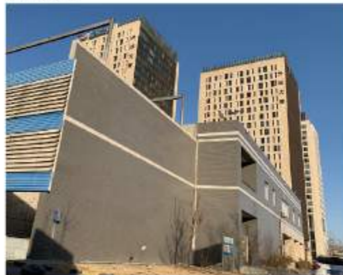
黄寺220kV变电站
