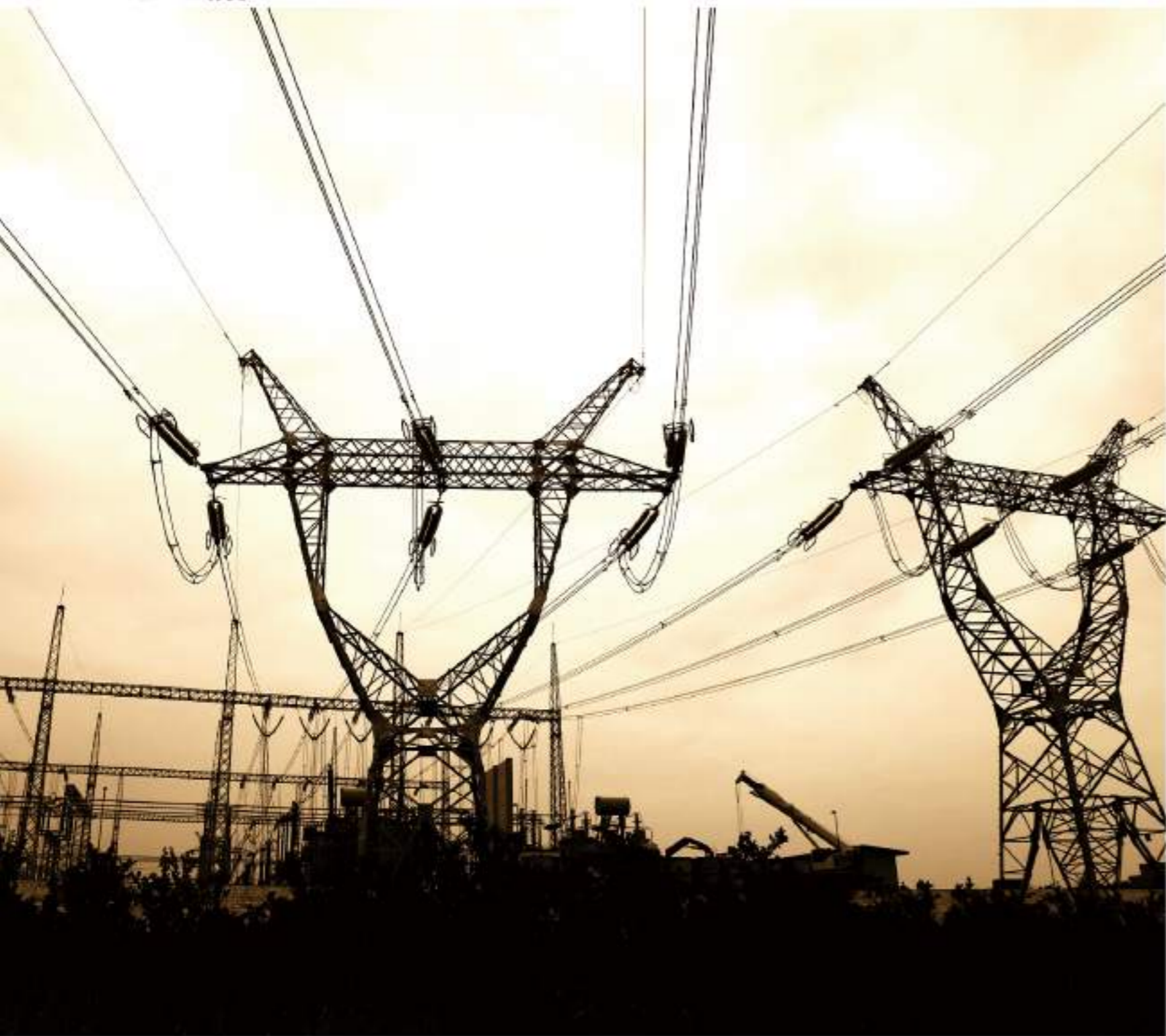
N ZETO 400kV变电站
