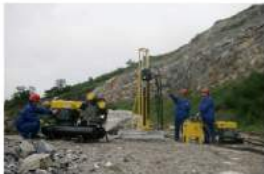
岩石锚杆基础施工
