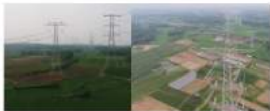
多回交直流高压线路同走廊输电
