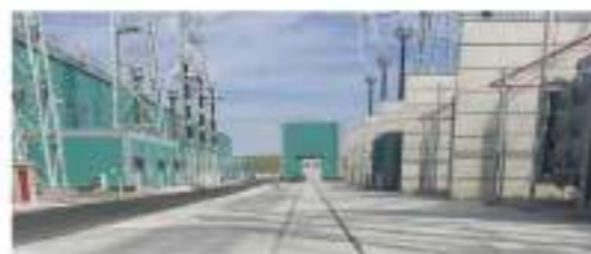
主变备用相故障停运轨道
