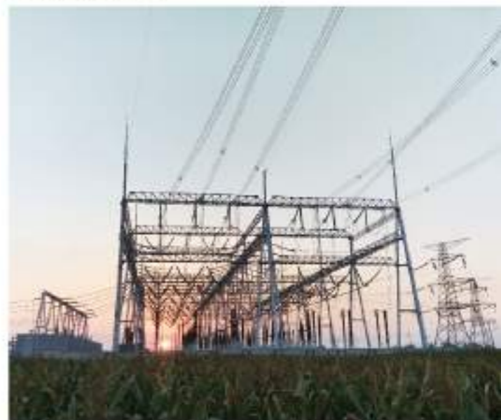
唐山乐亭500kV变电站工程
