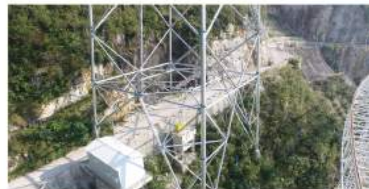
全方位长缆悬+索塔主柱基础
