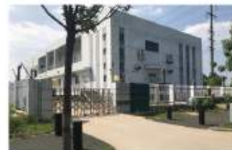
输电工程竣工水保验收
