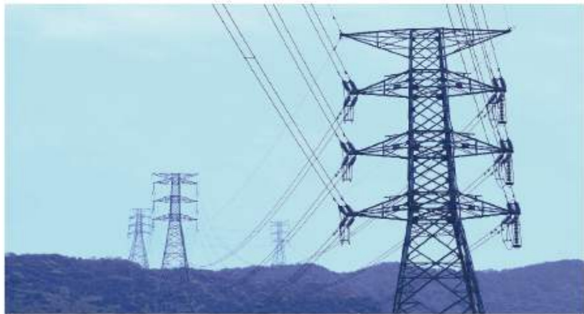
皖电东送淮南至上海特高压交流工程1000kV同塔双回线路
