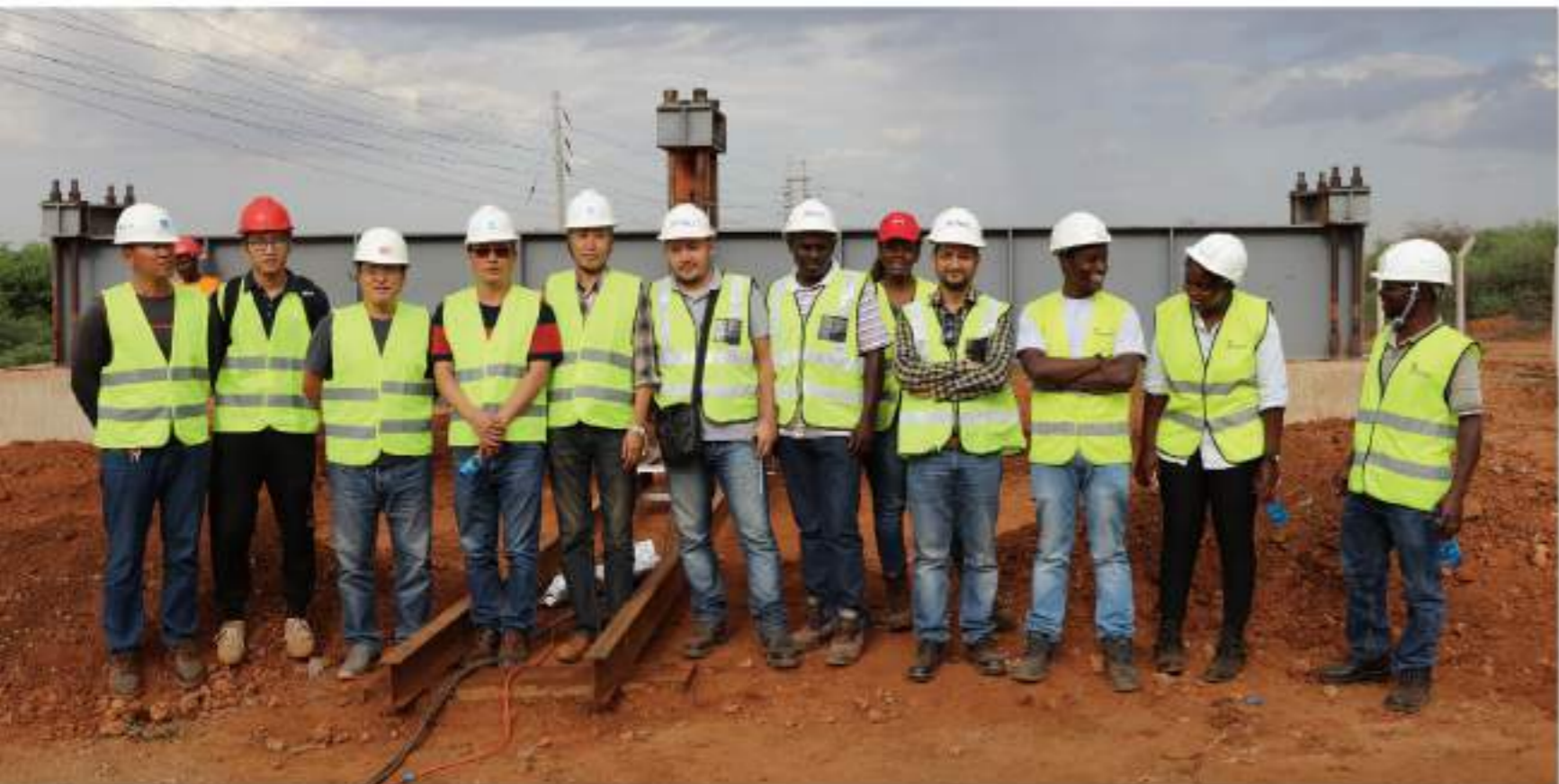
项目团队与业主、咨询工程师共同见证基础试桩一次成功
