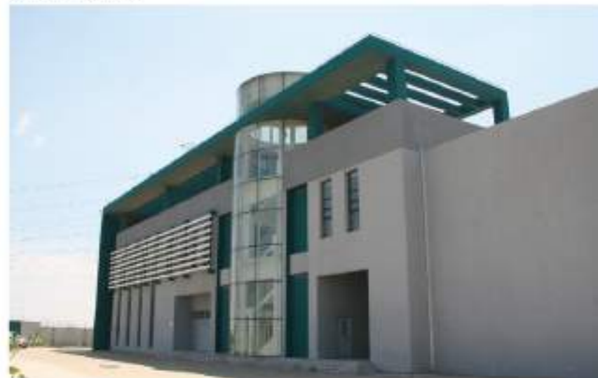
天津空港220kV变电站
