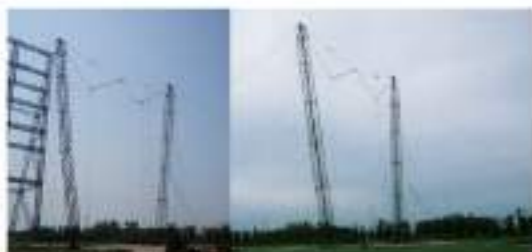
高耸杆塔(悬索塔)荷载试验
