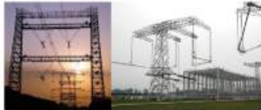
特高压直流试验基地工程试接线段移动模架试验塔
