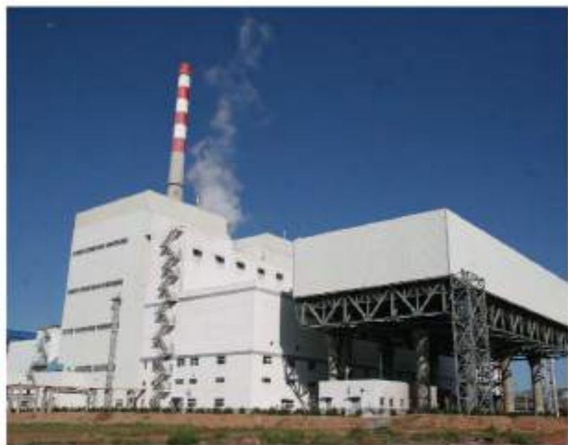
神华神东油白备热电厂总承包工程
