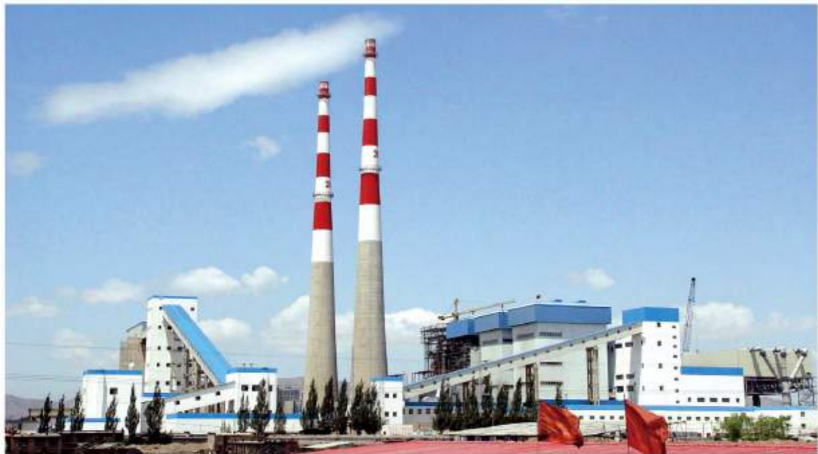
山西大同煤矿集团资源综合利用电厂总承包工程
