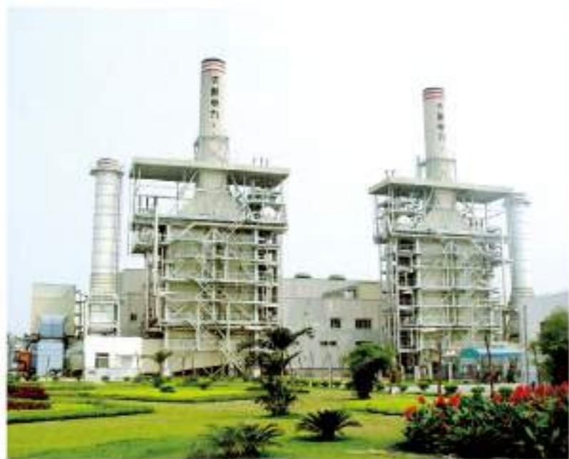
东莞天明、丰明电力有限公司燃机联合循环电厂工程总承包工程
