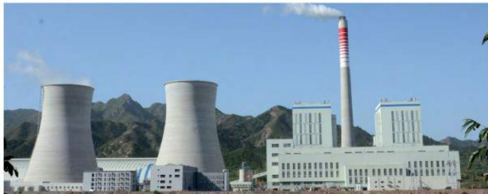
河北建投承德上板城2×350MW超临界热电联产EPC总承包工程
