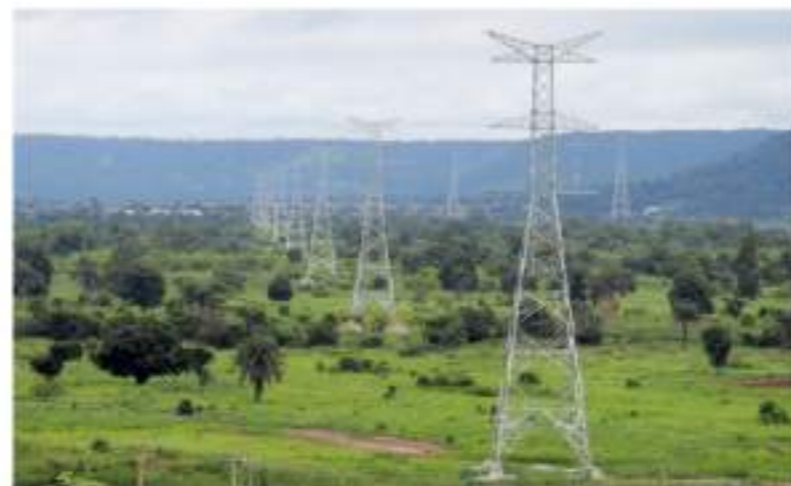
尼日利亚MAKURDI-JOS 330KV双回线路工程
