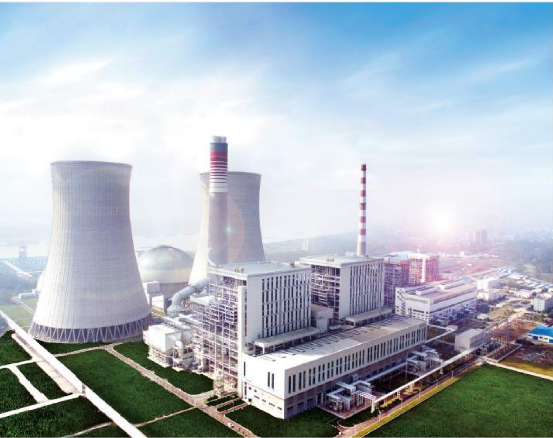
神皖安庆电厂二期2×1000MW扩建工程总承包—全国百万投产机组技术经济指标最优机组项目，获第八届优秀工程总承包项目金钥匙奖
