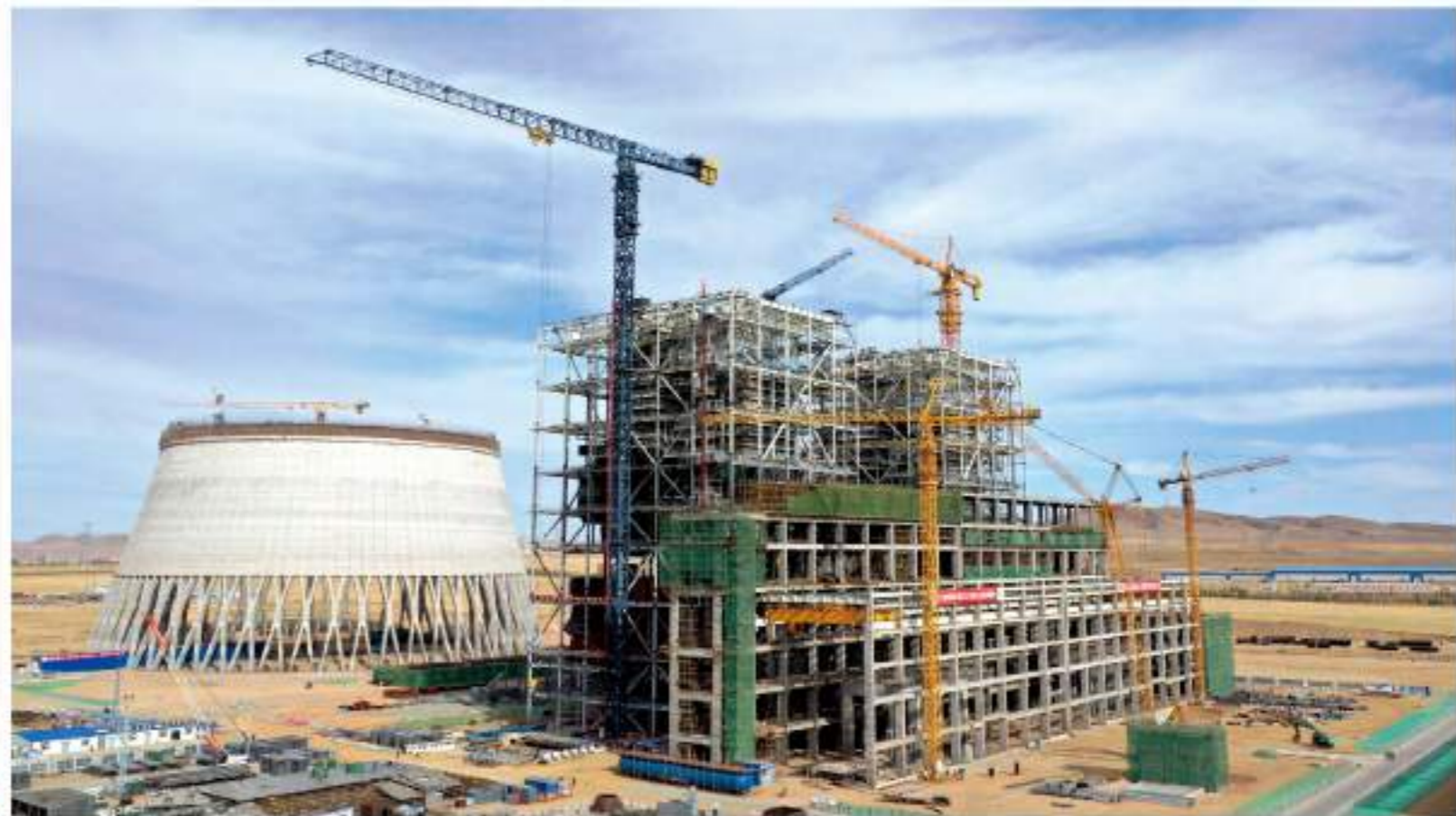
神华胜利2×660MW发电机组工程EPC总承包项目(在建项目)
