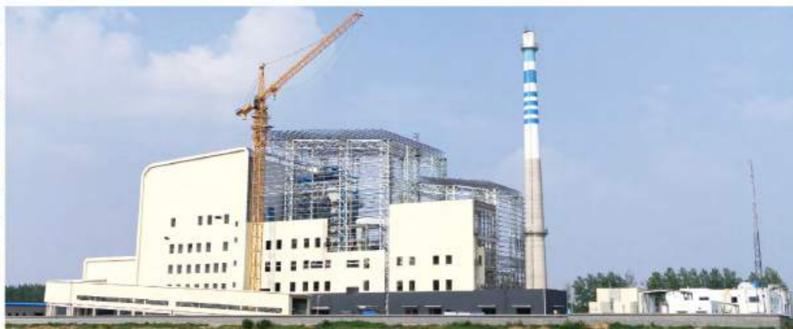
安徽省五河县生活垃圾焚烧发电项目(在建项目)
