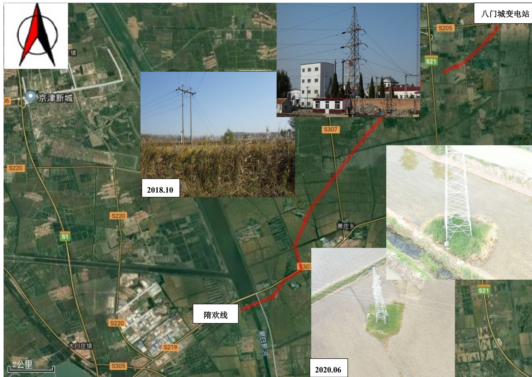
建设前后八门城 35 千伏变电站扩建工程
