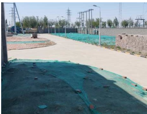
变电站密目网苫盖
