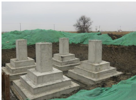
塔基密目网铺垫
