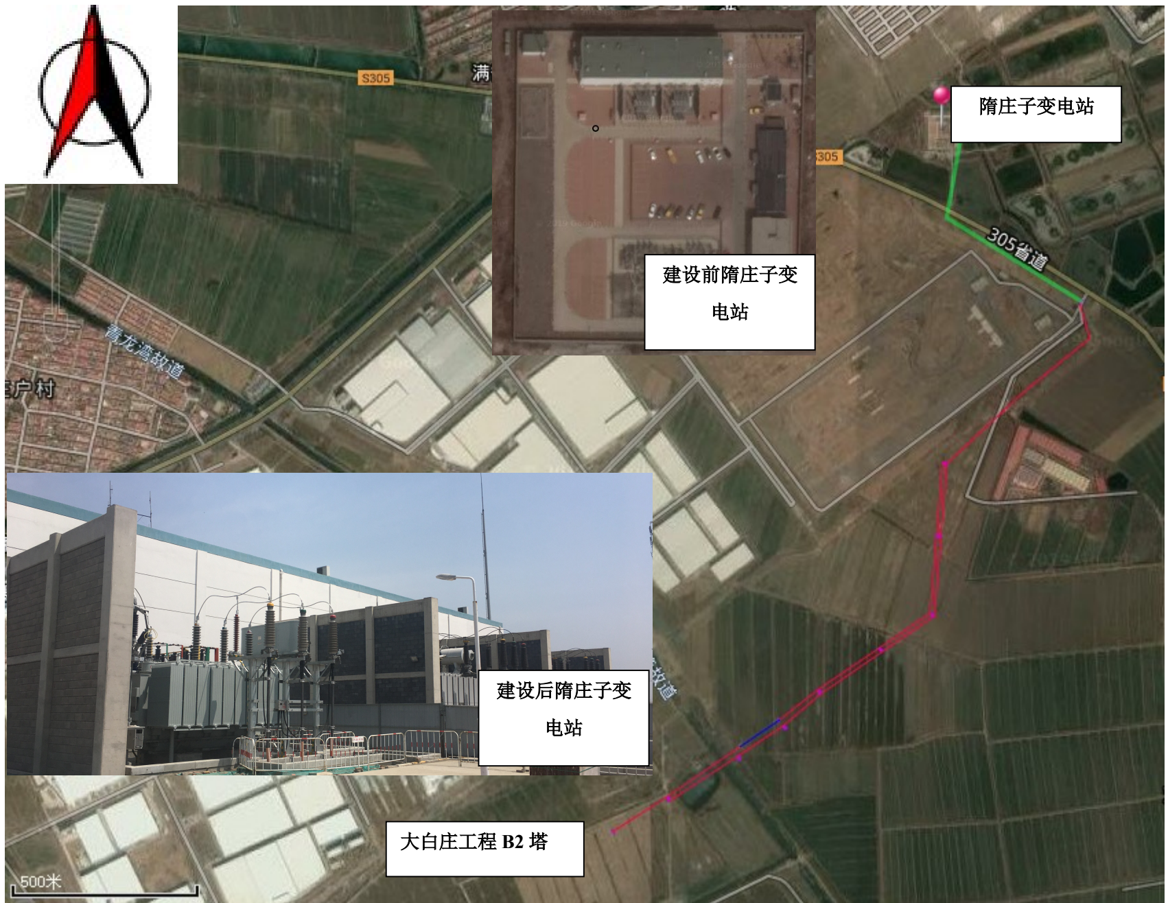
建设前后隋庄子 110 千伏变电站扩建工程
