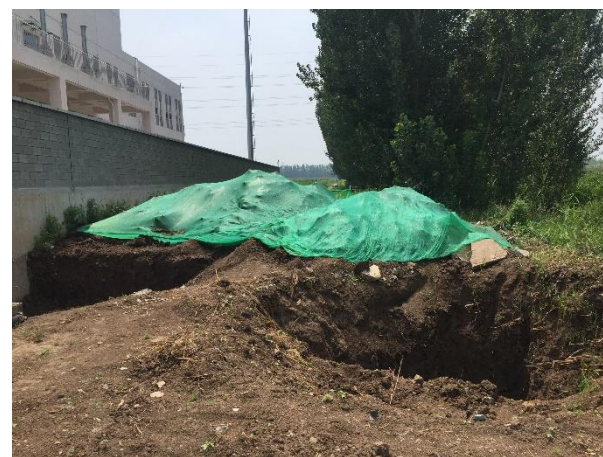
电缆沟施工（二）
