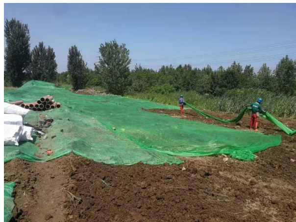
电缆施工区域临时苫盖（一）
