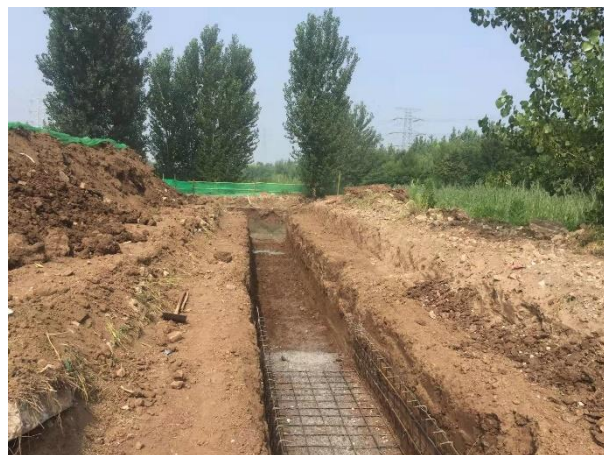
电缆沟施工（一）
