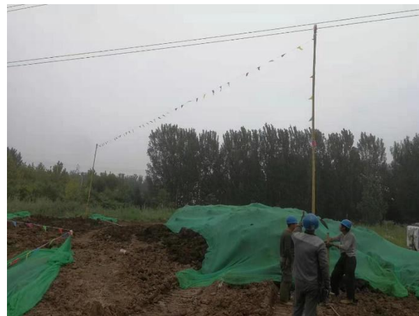
电缆施工区域临时苫盖（二）
