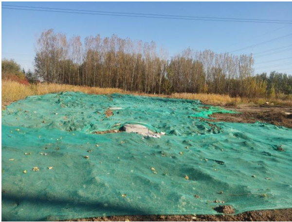
电缆施工区域临时苫盖（三）
