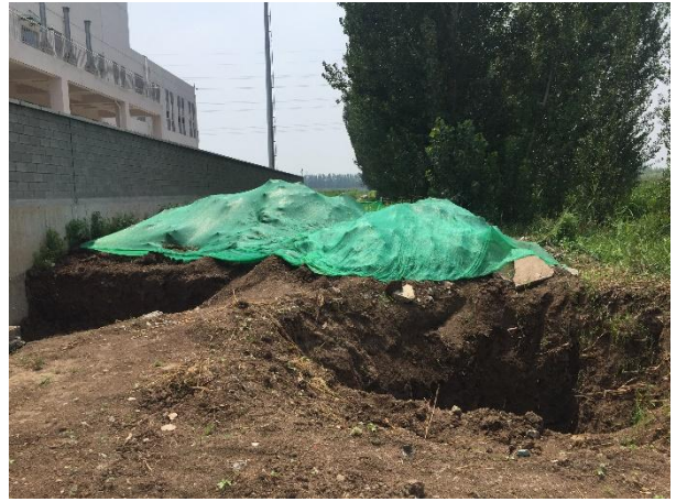
电缆沟施工（二）
