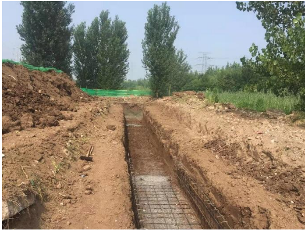
电缆沟施工（一）
