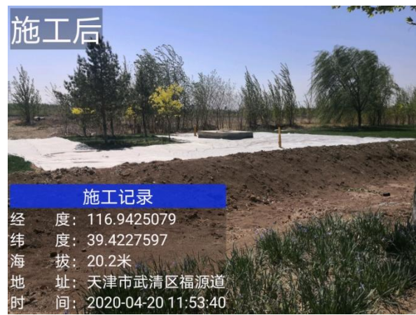
施工后场地清理及苫盖
