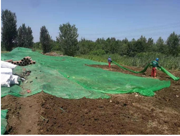
电缆施工区域临时苫盖（一）
