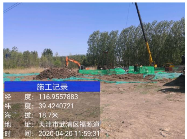
顶管施工区域
