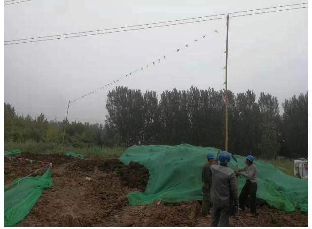
电缆施工区域临时苫盖（二）
