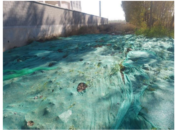
电缆施工区域临时苫盖（四）
