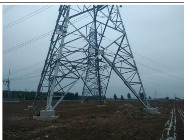
AN99 塔基植被恢复
