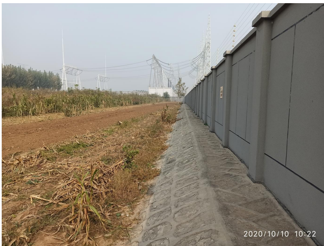
附图 4 本期工程占地区域现状
