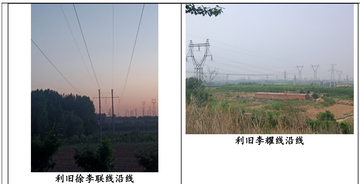
图 4-3 本工程变电站及输电线路沿线情况
