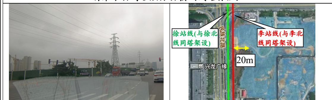
在建北城云海小区
